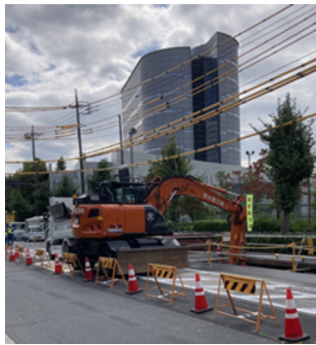
都立大前の工事
